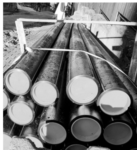
Fektetésre váró vízcsövek
